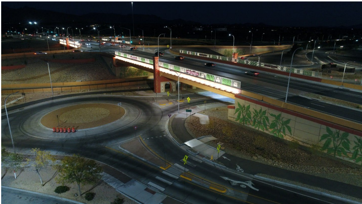
I-25/University Avenue Interchange, Las Cruces, NM. Photo: Molzen Corbin.
