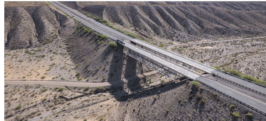
Puentes existentes 6776 and 6777
