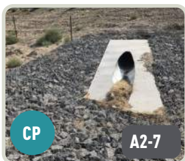
CP A2-7 CULVERT PROTECTION
